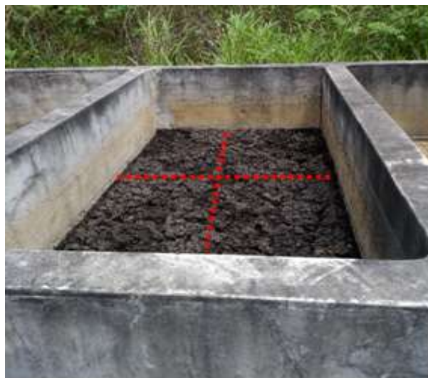
Figura 10: Leito de secagem para a estabilização lodo de esgoto doméstico localizado na Universidade Estadual de Feira de Santana.
