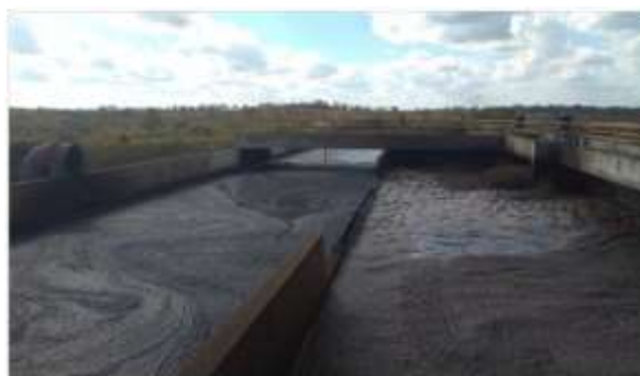
Figura 5: Lagoas aeradas ETE Jacuípe II de Feira de Santana-Ba (Fundação Escola Politécnica, 2017).
