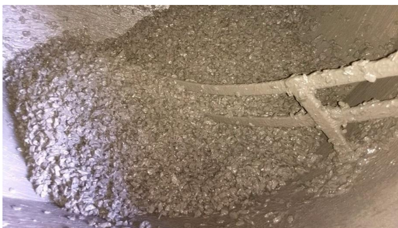
Figura 14: Aspecto do concreto permeável após a mistura em betoneira
